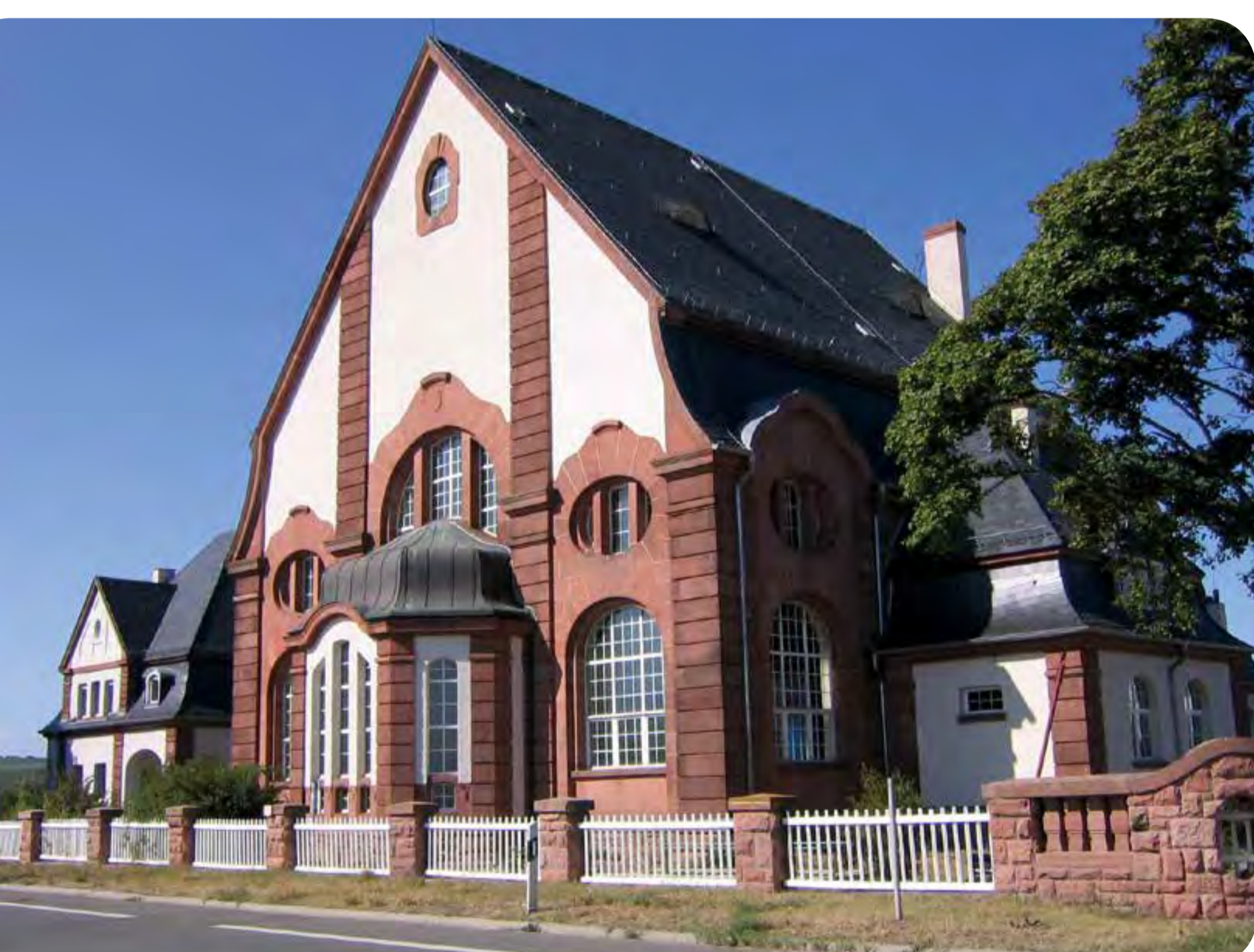
» 1906/07 wurde das Wasserwerk Guntersblum zur besseren Versorgung der Bevölkerung errichtet. Es ist ein Dokument des technischen Fortschritts und wurde in neobarocken Formen mit deutlichen Einflüssen des Jugendstils erbaut. (Quelle: Bildarchiv Institut für Geschichtliche Landeskunde)
