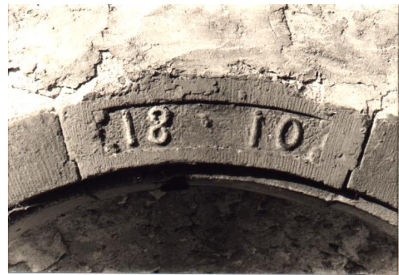
1810, Neubau der Scheune. 31
