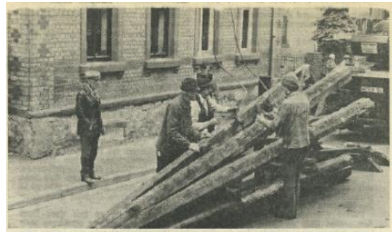
AUF DER EVANGELISCHEN KIRCHE in Nieder-Olm thront ein neuer Turm (siehe Bild unten). Das alte Gebälk (oben) mußte wegen seiner Baulälligkeit ausgetauscht werden. Mit einem großen Kranwagen war diese Arbeit jedoch in kürzester Zeit erledigt. Bewundernd schauten zahlreiche Passanten diesem imposanten Schauspiel zu. Bilder: Rudi Klos
