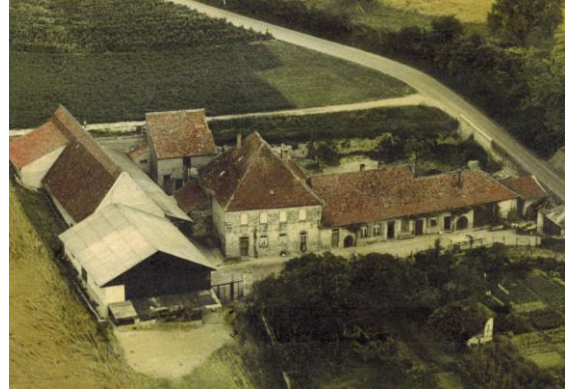
Wingertsmühle, Luftaufnahme aus den 1950er Jahren. 8
