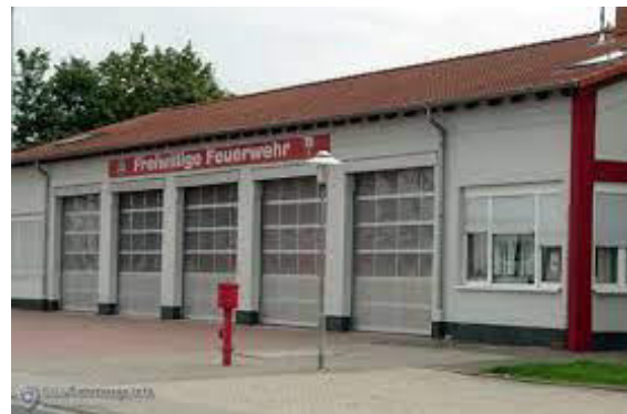
Auf Initiative und der Planung von Johann Plattner wurde 1964 das Feuerwehrhaus "Am Engelborn" gebaut. 3
