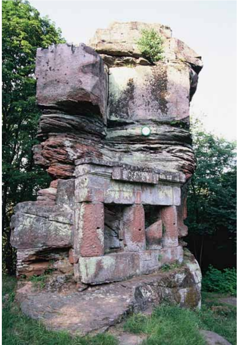
Reste des Merkurtempels auf der Wasenburg
