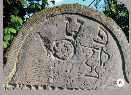
05 Bearbeitungstechniken, (a) gestockt/gespitzt, (b) scharriert
