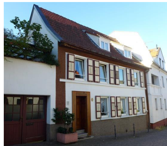
Ehemalige Bäckerei von Simon Walz, Backhausstraße Nr. 4. 31
