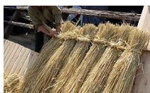
Strohbindel als Dacheindeckung. 17
