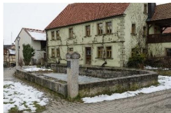
Beispiel einer noch erhaltenen Weed als Löschwasserteich und Pferdeschwemme. 30
