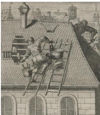
17. Jh., die Dachdecker.
