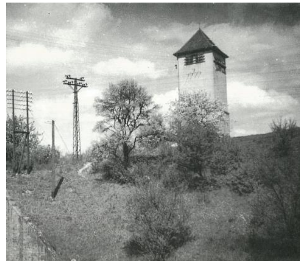
Die erste Transformatorstation aus dem Jahr 1911 an der Ebersheimer Brücke. 4
