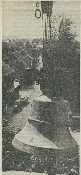
MIT EINEM SEILZUG wurden die Glocken langsam in die Höhe gezogen.
