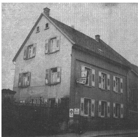
1967, Raiffeisengenossenschaft, Oppenheimer Straße Nr. 13.
