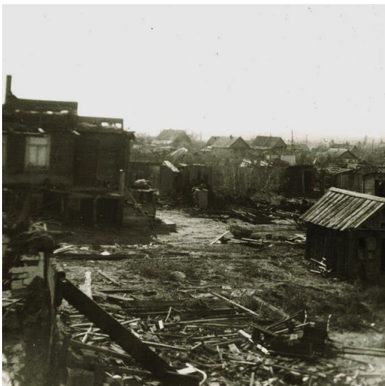
Kriegsschäden in der Ortsmitte. 21
