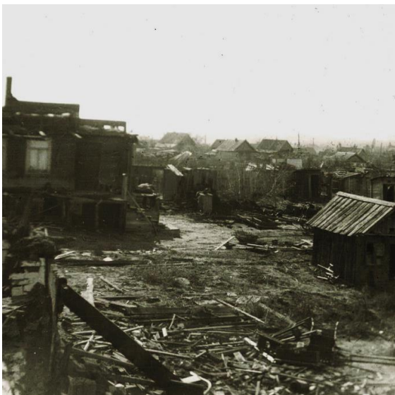
Kriegsschäden in der Ortsmitte. 21
