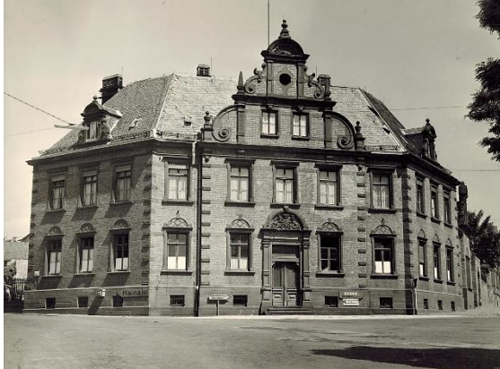
1893-1894, Neubau des Amtsgerichts, Vorderseite. 42
