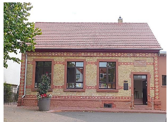
Der ehemalige Kindergarten, Pfarrgasse. 70
