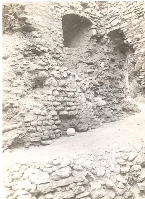
1950, Teile der östlichen Burggrabenmauer. 10
