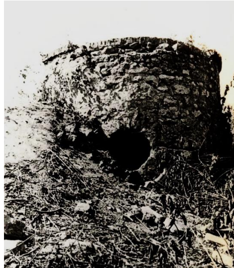
1950, Rest des an der Burggrabenmauer gelegenen Ostturms. 9
