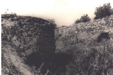
1950, gemauerter Turmstumpf, im Hintergrund Reste der Burggrabenmauer. 8
