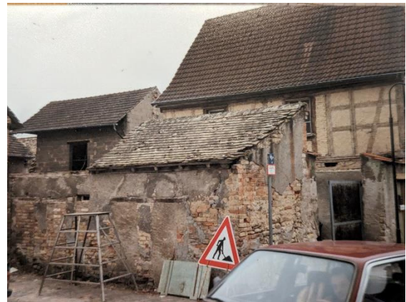
Alter Bauzustand und begonnene Sanierungsarbeiten. 25
