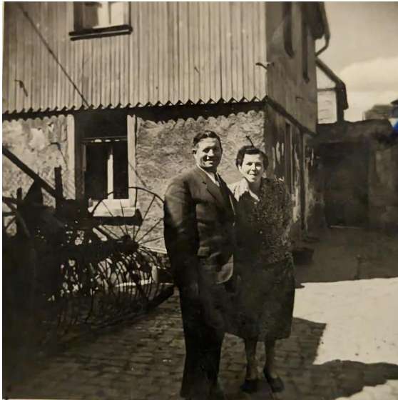
1956, Eheleute Stenner. Das Fachwerk ist noch mit einer Brettschalung verkleidet. 23
