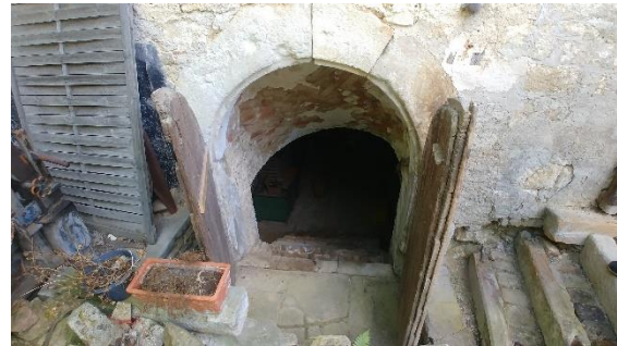
Kellerniedergang im Scheunenbereich. 4
