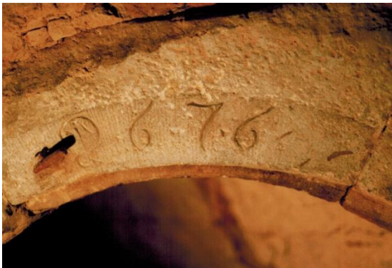
1676, Inschrift im Sandsteingewände an der Kellertreppe. 33
