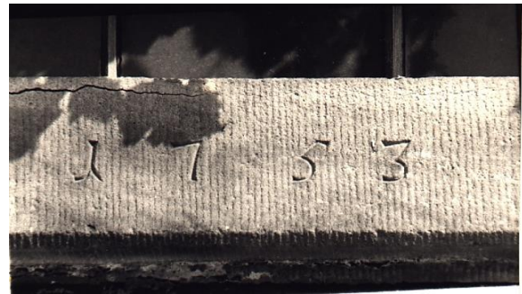
1753, Türsturz am Nebengebäude. 41
