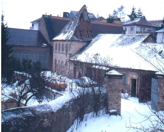
1987, das Dach des Haupthauses ist eingestürzt. 64
