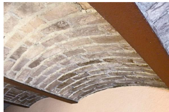
Preußische Kappendecke mit gewölbter Backsteinfüllung. 46
