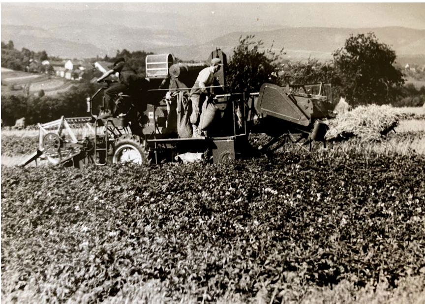
Mähdrescher um 1960. Mähdrescher kombinieren die Arbeitsvorgänge des Mähens und des Dreschens. Das Getreide wird von Spreu und Stroh getrennt und in Säcken gesammelt. Foto: Kreisbildstelle Saarburg, KATr-Sbg, Fo F 7-6.
