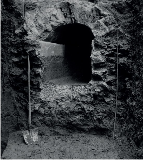
Foto vom Kanalquerschnitt der Ruwerleitung. Deutlich ist die durch den Kalkfraß hervorgerufene Aufrauung des Putzes im Leitungsinernen zu erkennen. Befundfoto im Bereich des ehem. Löwenbrauerei in Trier. © GDKE/Rheinisches Landesmuseum Trier C.6067, Archivfoto.
