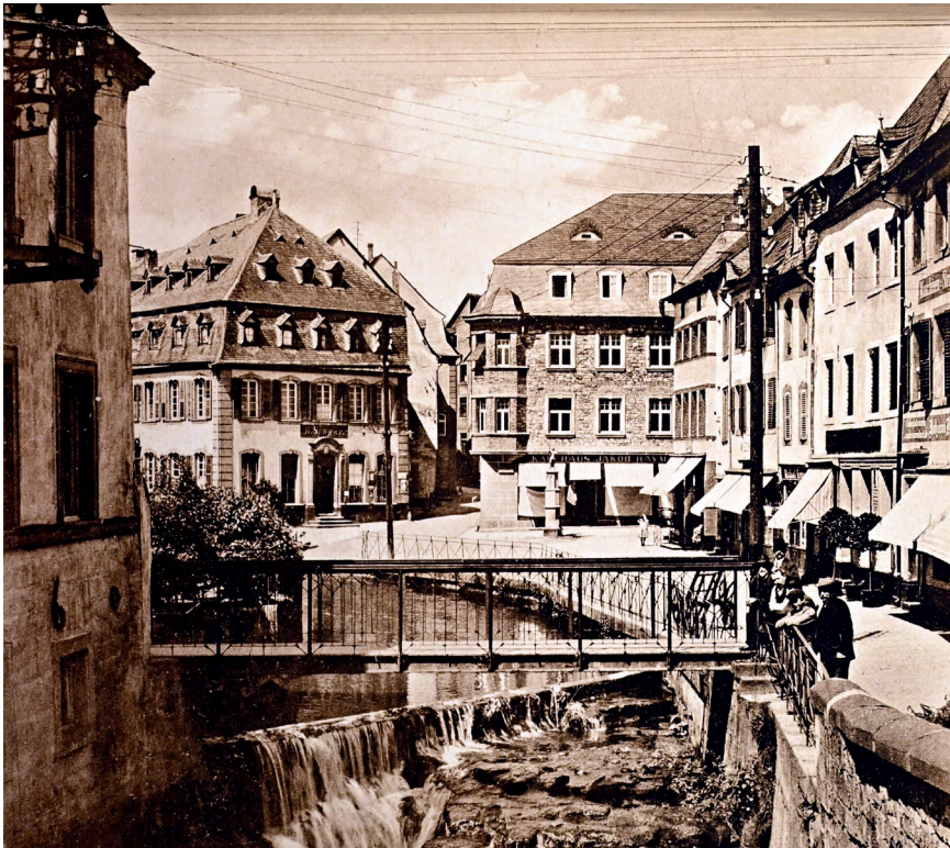
Dieses Foto mit Blick auf den Buttermarkt zeigt einige interessante technische Details der Stromversorgung durch das Elektrizitätswerk Saarburg-Beurig. An der Rückseite der alten Stadtmühle ist ein Abspannrahmen angebracht (siehe linke obere Bildecke), von dem eine größere Zahl von Niederspannungs- und Straßenbeleuchtungsstromkreisen über Holzmasten zu den einzelnen Abnehmern geführt sind. An dem Holzmast in Bildmitte sind in halber Masthöhe zwei Leuchten angebracht, die zur Beleuchtung des Platzes und der hier durch die Leuk führenden Furt dienen. Im Vordergrund das Überfallwehr und die Fußgängerbrücke über den Wasserfall. Die Instandhaltung dieser Brücke oblag dem Elektrizitätswerk. Foto: Amüseum.
