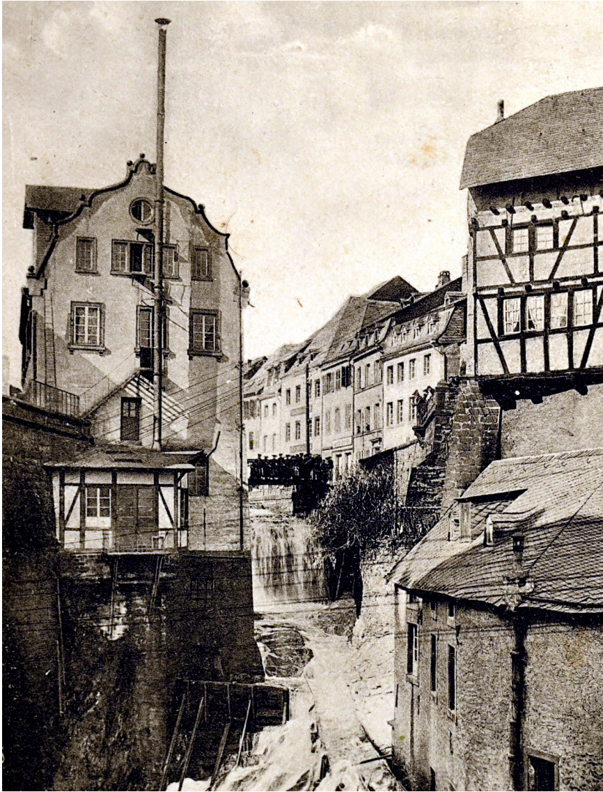
Ansichtskarte, aufgenommen etwa 1900, mit dem Foto des Wasserfalls der Leuk und der angrenzenden Bebauung. Das Elektrizitätswerk mit seinem nachempfundenen Renaissance-Giebel befindet sich am linken Bildrand, direkt an der sog. Tümpelmauer. Man erkennt den in Fachwerkbauweise in etwa halber Höhe an die Tümpelmauer und das EW errichteten Anbau für die Lokomobile, aus dem ein Metall-Rauchabzugrohr entlang des Giebels bis weit über das Dach des Gebäudes geführt ist. Rechts die am Tümpel liegende Mühle Hackenberger mit der hölzernen Wasserrinne zum Betrieb der dort befindlichen überschlächtigen Wasserräder. Foto: Amüseum.
