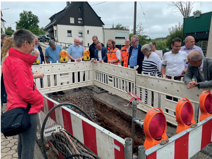
Die Kommunalpolitiker machen sich vor Ort ein Bild von den Baumaßnahmen. Foto: Hannah Schmitz, Pressestelle der Kreisverwaltung.
